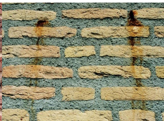
Roestende pyrietpitten in voegwerk (2.5.b)
