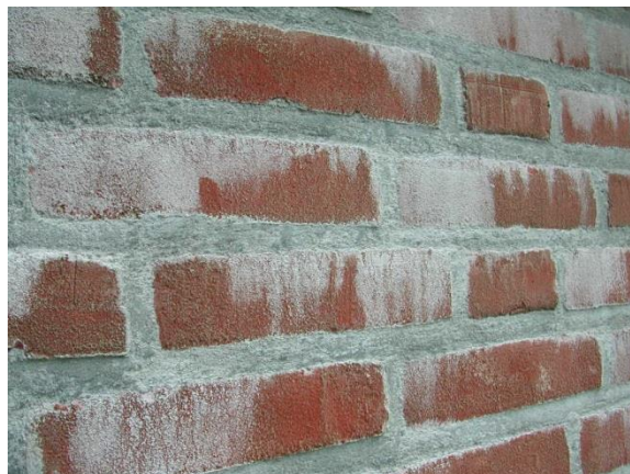
Uitspoelen van kalk uit vers voegwerk (2.1.b)
