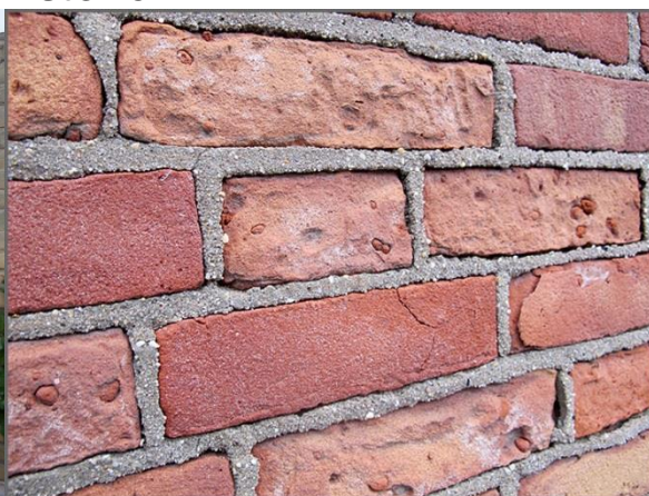
Schade aan metselwerk door binnengedrongen zeezout (2.1.a)
