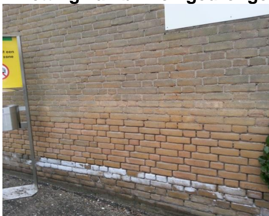
Witte uitbloei en schade aan voegwerk door doozout (2.1.a)
