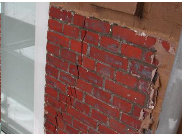
Resten van lijnolie op metselwerk na verwijderen van de verf (2.3.b)
