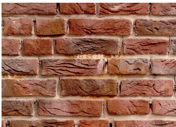
Roest van pyriet op stenen (2.5.b)
