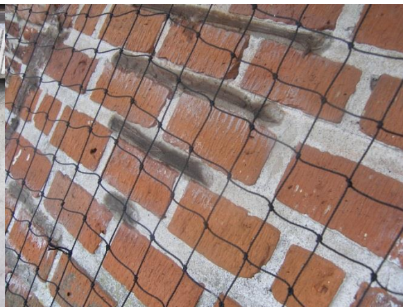
Verkleuring door weekmakers uit vogelweringskit (2.3.b)
