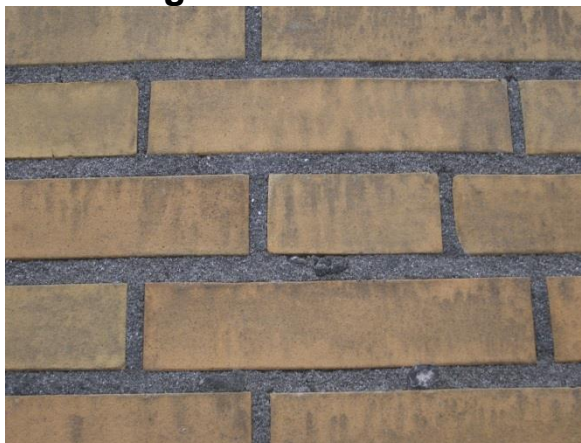
Neerslag van losse ijzerdeeltjes en organische Deeltjes (2.3, 2.5.a)
