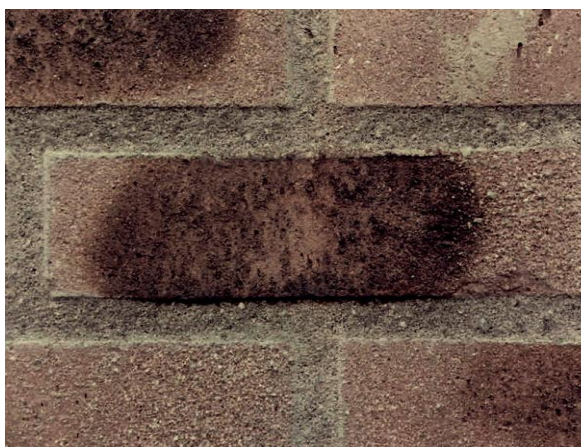
Mangaanroest op een strengperssteen (2.5.c)
