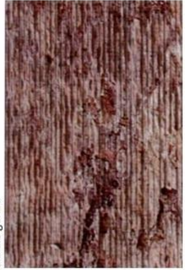
2.1.2.2 machinaal ingezaagd en gehakt
