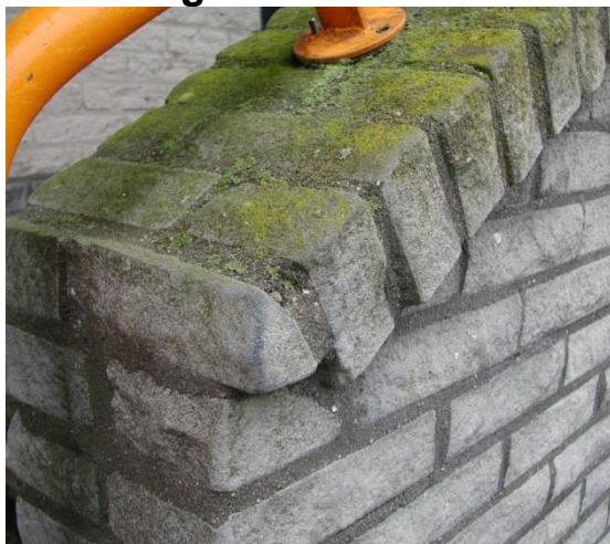
Algen en mossen op een rollaag (2.4.a)
