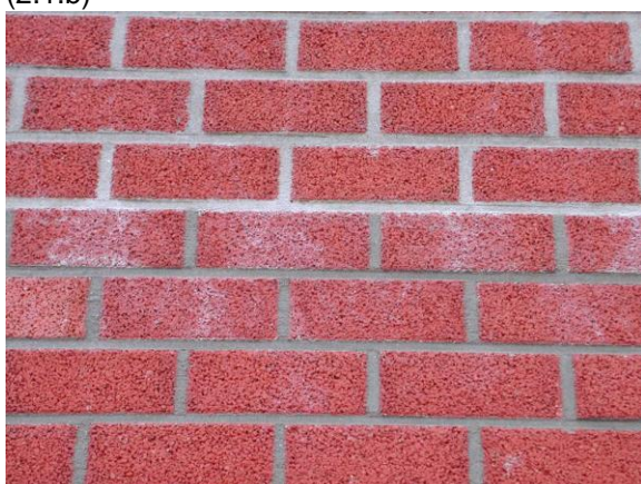
Kleurverschil in voegwerk door uitbloei van kalk uit de voegmortel (2.1.b)
