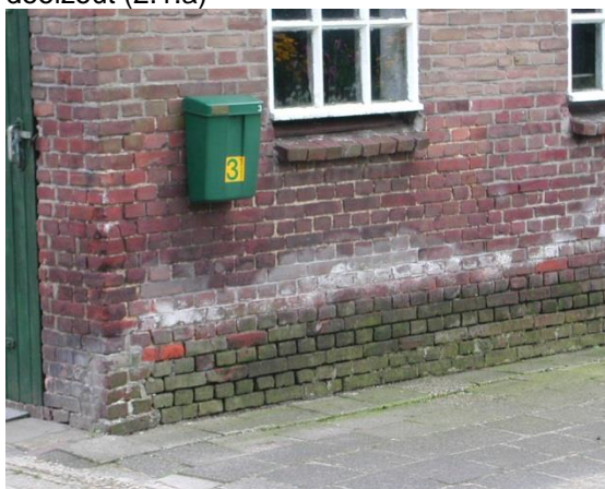
Uitbloei van nitraat op een stal (2.1.a)
