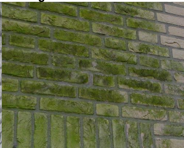
Alggroei door ondeskundig reinigen met een middel op basis van fosforzuur (2.4.a)
