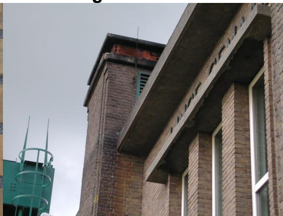
Vervuiling door roet (2.3.b)
